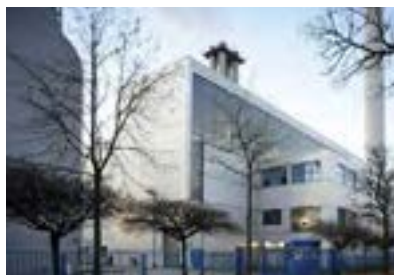
Biomasse-Heizkraftwerk Märkisches Viertel
