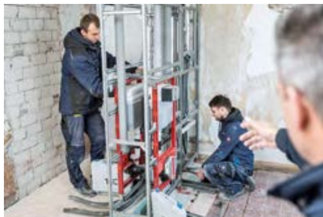
Die Installationswände von TECEsystem kommen komplett individuell vorgefertigt und verrohrt auf die Baustelle.
